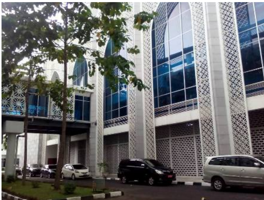
Gedung DPRD Sumut Jalan Imam Bonjol Medan. (Foto:lintasMedan/ist)
