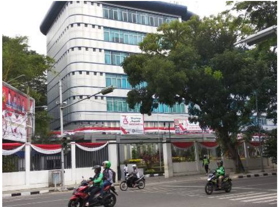
Gedung DPRD Kota Medan. (Foto: LintasMedan/Irma)
